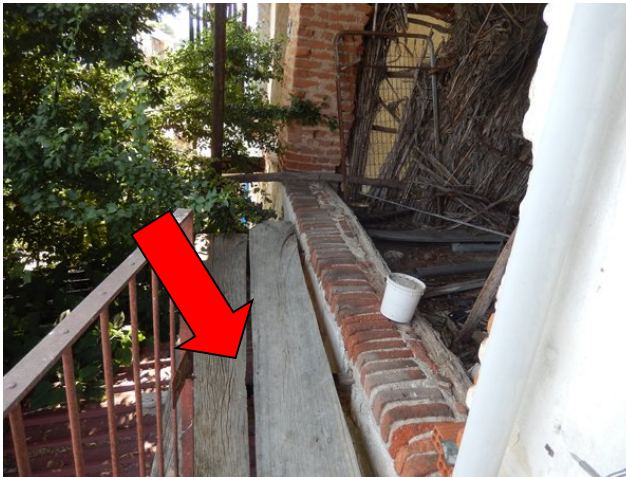
Accesso al locale travata
