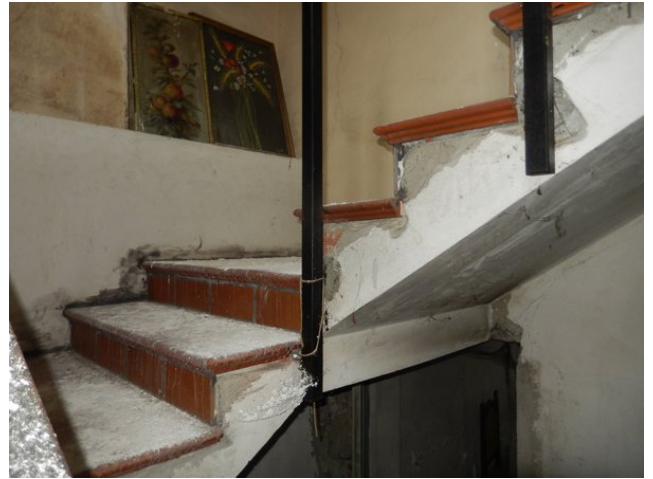
Scala di accesso al piano 1
