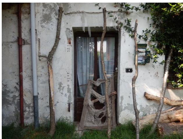
Porta di accesso immobile
